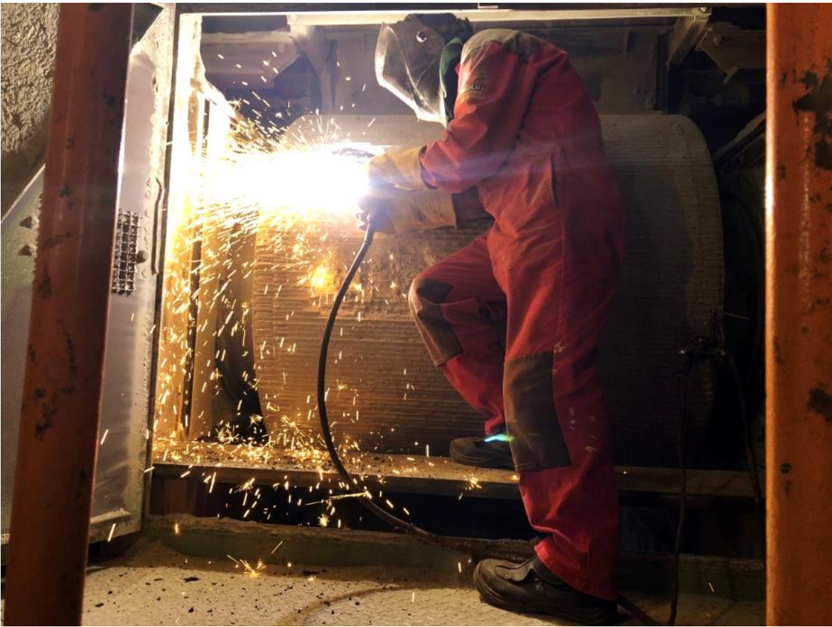
Žlijebljenje i navarivanje oštećenja rolo prese
